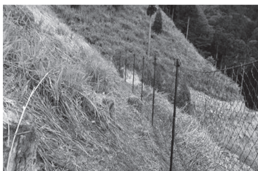
防護柵設置地
