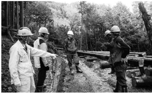
作業現場確認中
